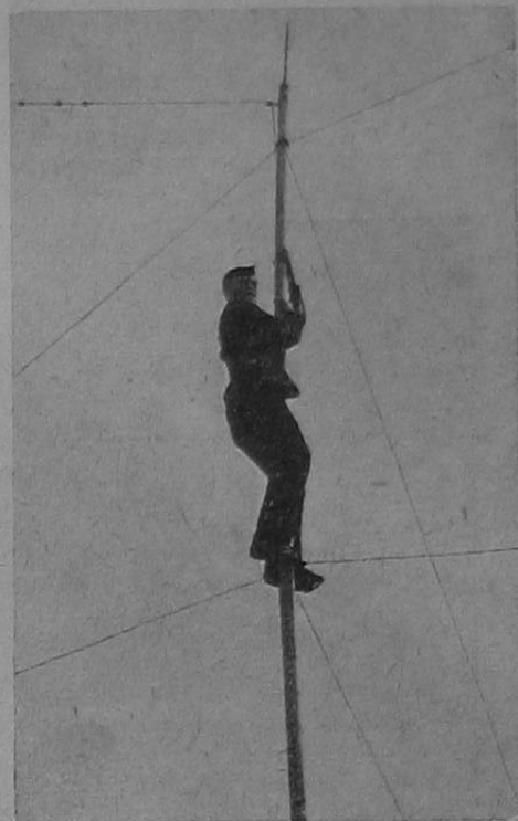
Ремонт антенны опытно-показательной школы, МОНО (Москва).
